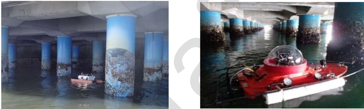
Ảnh 2.2.5 Khảo sát mặt dưới của cầu cảng sử dụng ROV chuyên dụng và tàu điều khiển từ xa cỡ nhỏ
