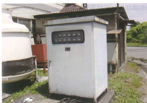
Hình 2.7.3 Trạm cung cấp điện bổ sung và tình trạng kiểm định
