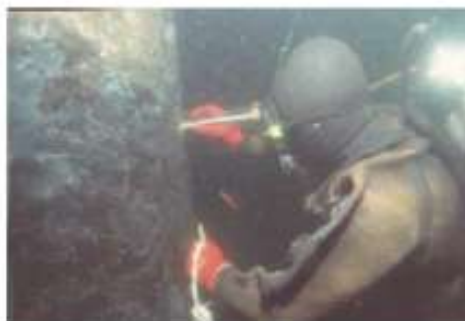
Ảnh 2.2.2 Khảo sát trực quan phần dưới mặt nước của tường cừ thép
