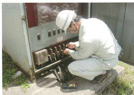
Hình 2.7.3 Trạm cung cấp điện bổ sung và tình trạng kiểm định
