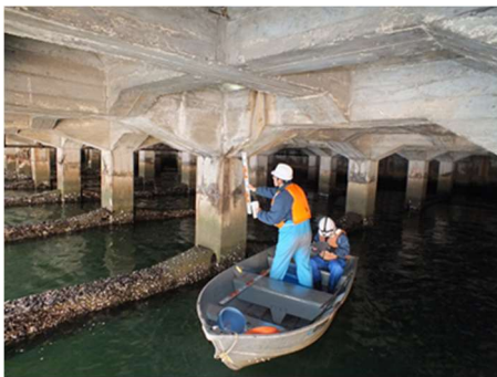
Ảnh 2.2.1 Khảo sát trực quan kết cấu phần trên của cầu tàu
