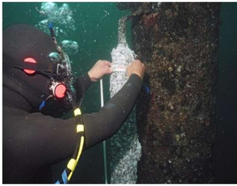
Ảnh 2.7.2 Khảo sát tính trạng Anod bằng thợ lặn
