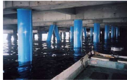
Hình 2.7.1 Ví dụ về phương pháp bảo vệ chống ăn mòn được áp dụng cho bến bệ cọc cao
