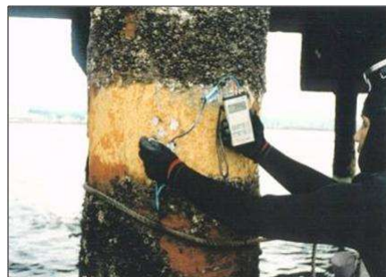
Hình 2.7.4 Khảo sát đo chiều dày thành cọc
