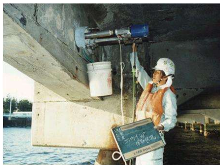
Ảnh 2.6.2 Quá trình khoan lấy mẫu lõi bê tông
