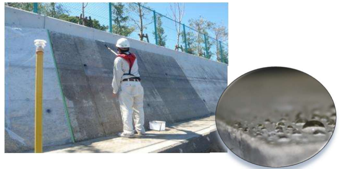
Hình 3.4.2 Ứng dụng vật liệu thẩm thấu bề mặt và trạng thái chống thấm nước
