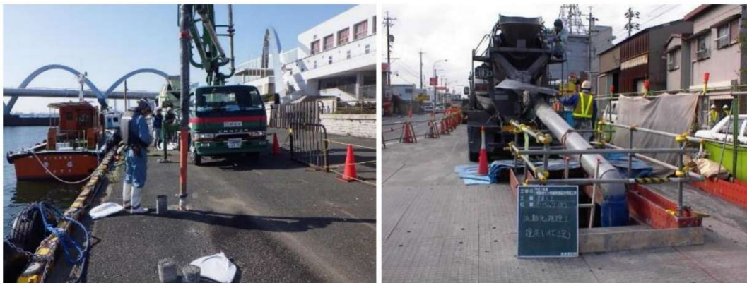
(a) Bơm lấp (hốc rỗng) bằng xe bơm bê tông
