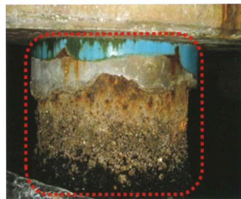
• Hư hỏng vỏ bảo vệ và bong tróc lớp vữa (mức độ suy giảm: a)
