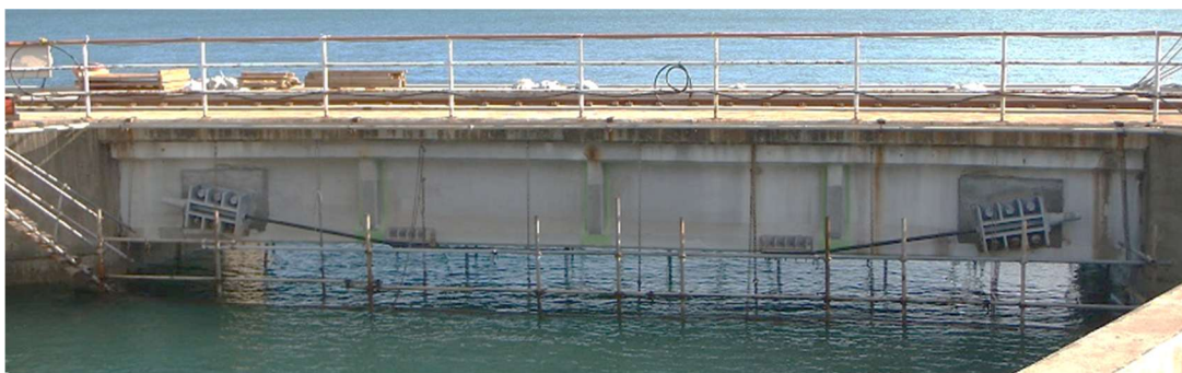
Ảnh 3.4.8 Ví dụ gia cố bằng phương pháp cáp ngoài
