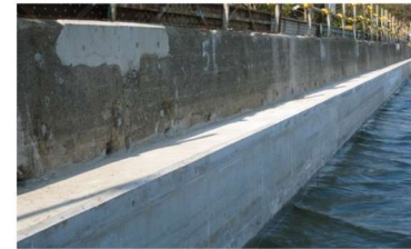
Hình 3.5.7 Ví dụ về sửa chữa và gia cố cừ thép bản bằng cách tăng bề dày bằng bê tông cốt thép
