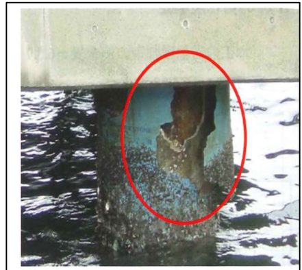
• Hư hỏng vỏ bảo vệ do va chạm với các vật thể trôi dạt (mức độ suy giảm : a)
