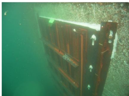
Hình 3.4.7 Ví dụ về lắp đặt ván khuôn ngoài 2)
