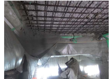
Ảnh 13 Thi công bê tông phun tại mặt dưới của bản sàn
