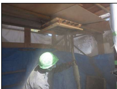
Ảnh 4 Ứng dụng bê tông phun cho thử nghiệm khả năng lấp đầy
