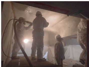
Ảnh 11 Thi công bê tông phun tại bề mặt bên của dầm
