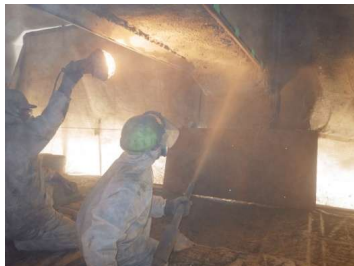
Ảnh 12 Thi công bê tông phun tại mặt dưới của dầm
