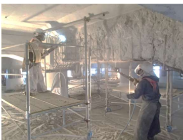
Ảnh 14 Phun đồng thời tại bề mặt bên và mặt dưới của dầm
