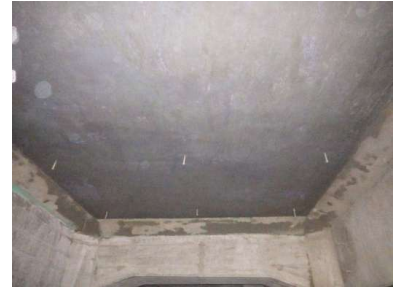
Ảnh 17 Bề mặt sàn hoàn thiện
