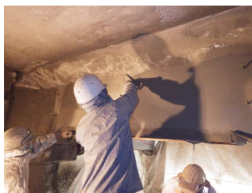
Ảnh 15 Hoàn thiện bằng bay trát ngay sau khi phun
