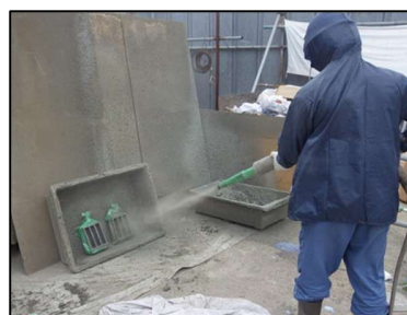
Ảnh 5 Thi công bê tông phun trong khuôn mẫu thử
