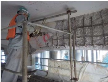
Ảnh 8 Loại bỏ bê tông bị hư hỏng ở bề mặt bên của dầm
