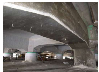
Ảnh 16 Bề mặt dầm hoàn thiện
