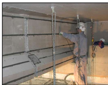
(b) Lắp đặt anot trong các rãnh
