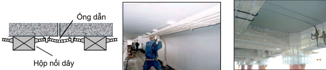
Hình 6 Đi dây và lắp đặt ống dẫn
