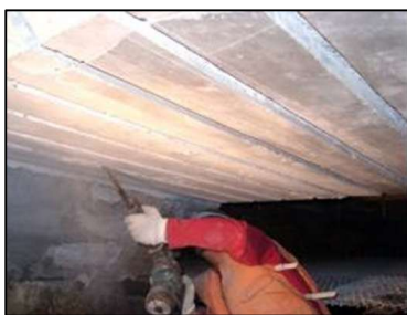
(a) Tạo rãnh lắp đặt
