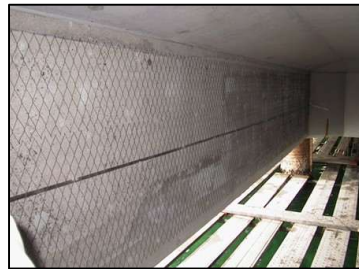
(b) Lắp đặt anot (dầm)
