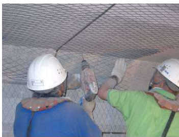
(a) Lắp đặt anot (bản sàn)
