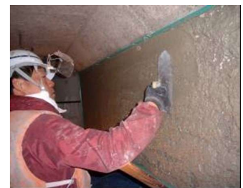
(c) Phủ lớp bê tông bảo vệ
