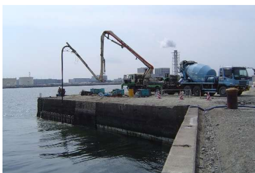
Ảnh 5 Thi công cấp phối bê tông
